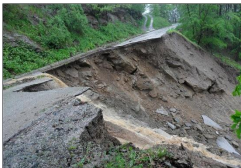
Sl. 3. Odron iniciran zasijecanjem labilne kolvijalne padine u Željeznom Polju Fig. 3. The landslide initiated by cutting the unstable colluvial slopes in the Željezno Polje
