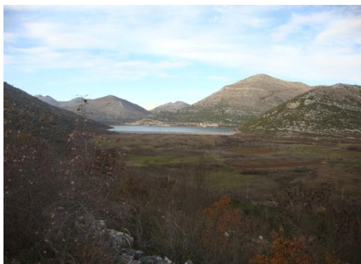
Sl. 2. Završetak Popovopoljske udoline kod Hutova sa vidljivim ostacima nekadašnjih ponora. Sada su krške pukotine injektirane betonskom ktlinom, u kojoj se vrši akumulacija voda Trebišnjice, a i reverzibilnim vodama iz Svitavskog jezera radom HE „Čapljina“
