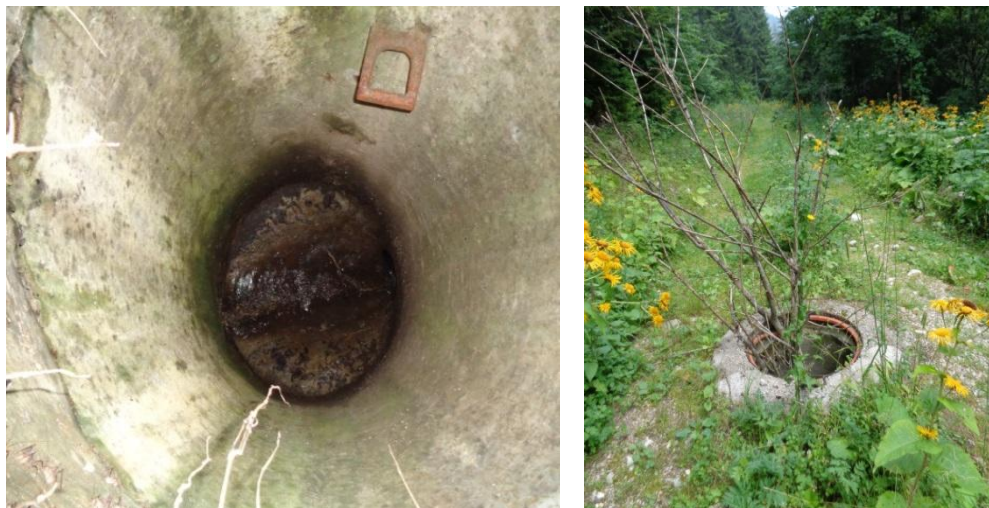
Sl. 3. Zapuštena kanalizaciona mreža na Igmanu lokalitet Brezovača, odakle je utvrđena direktna veza kroz krško podzemlje prema vrelima Bosne. Zapuštena kanalizaciona cijev mehaničkim otpadom (slika lijevo) i šaht-kanalizacione cijevi bez poklopca (slika desno).
