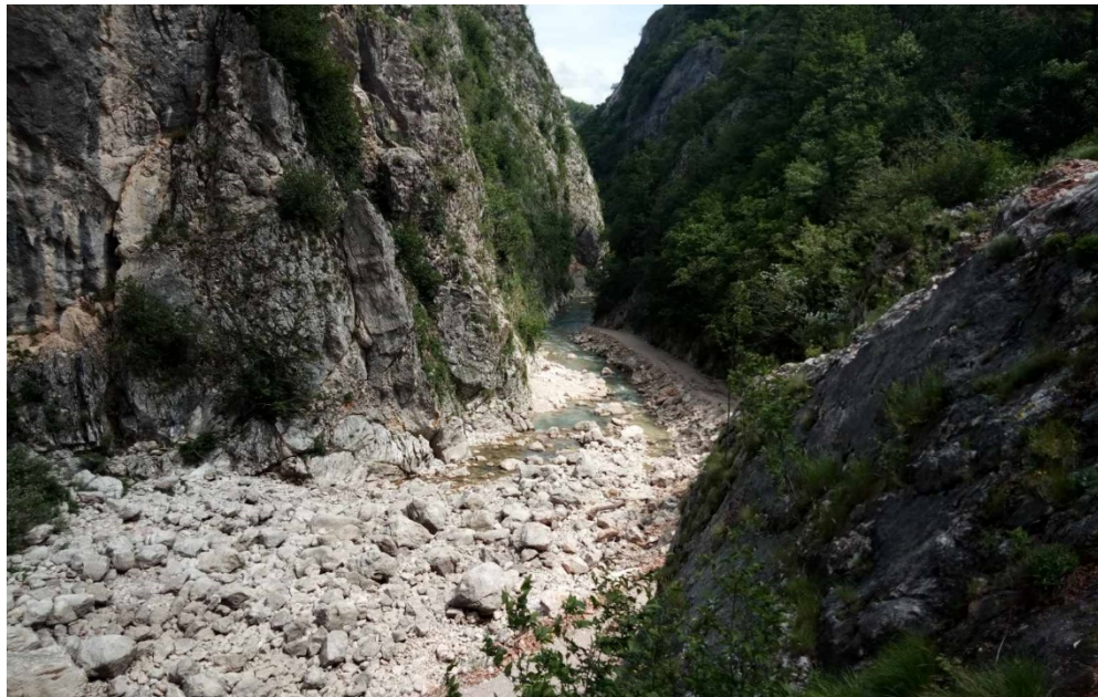
Sl. 1. Suho korito Neretvice uzvodno od Uloga zbog prevođenja vode cijevima na mini hidroelektranu
